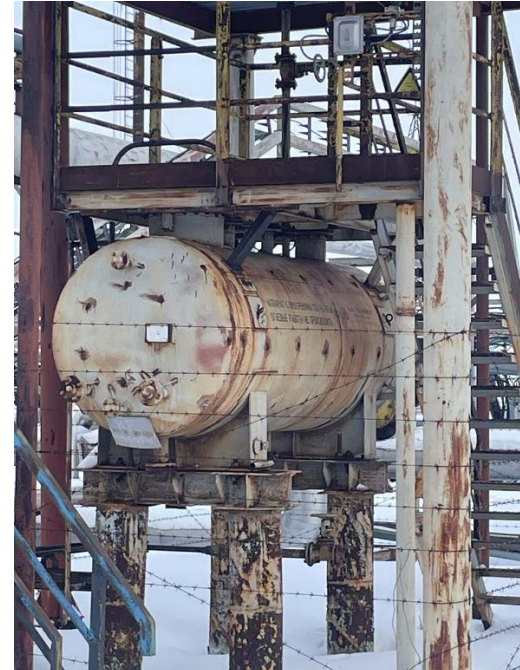
11.7 Емкость хранения метанола V-4м3
