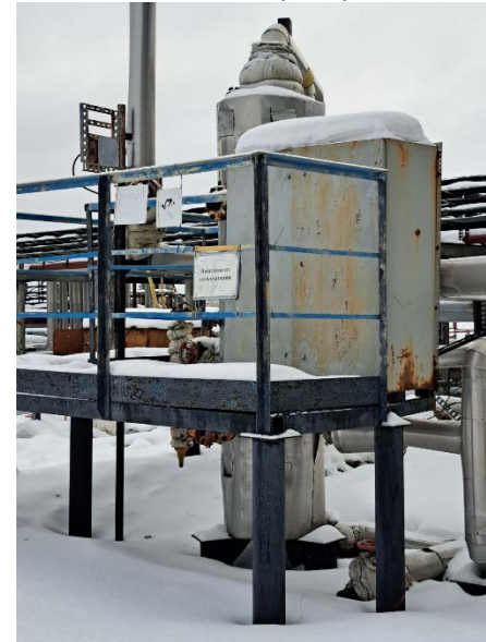
10.14 Газовый сепаратор ГС-4 V-0,8м3
