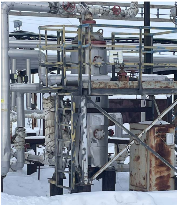
11.1 Газосепаратор ГС-2 V-0,8м3
