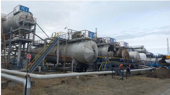
1.13-1.17 Электродегидратор ЭДГ -4-6, V-200м3, отстойник горизонтальный ОГ-3,4 V-200м3 (1)
