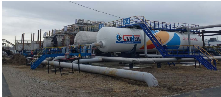
1.13-1.17 Электродегидратор ЭДГ -4-6, V-200м3, отстойник горизонтальный ОГ-3,4 V-200м3 (1)
