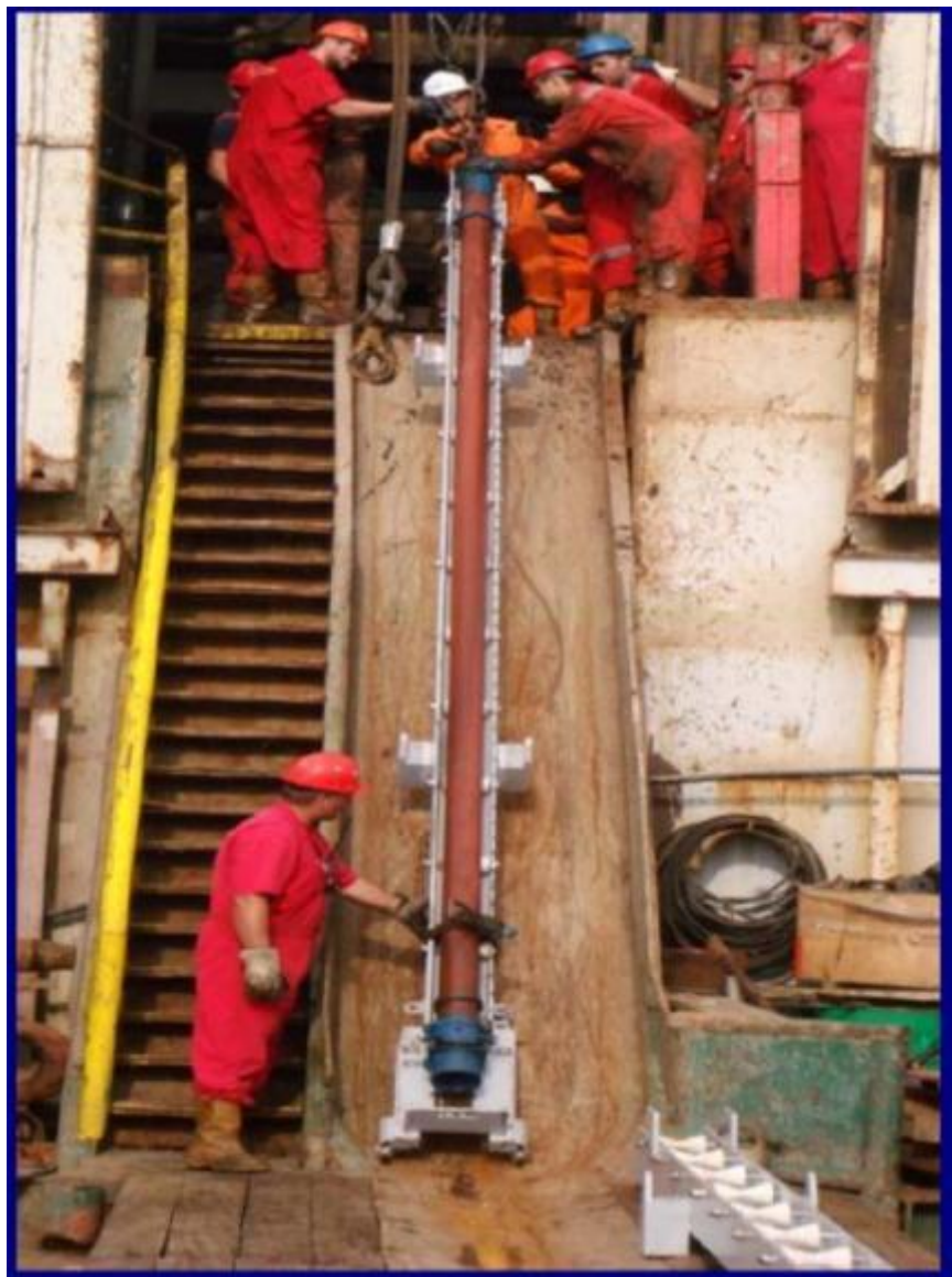
Рис. 19 Спуск внутренней керноприемной трубы с устройством, исключающим прогиб («укладочная рама»)
