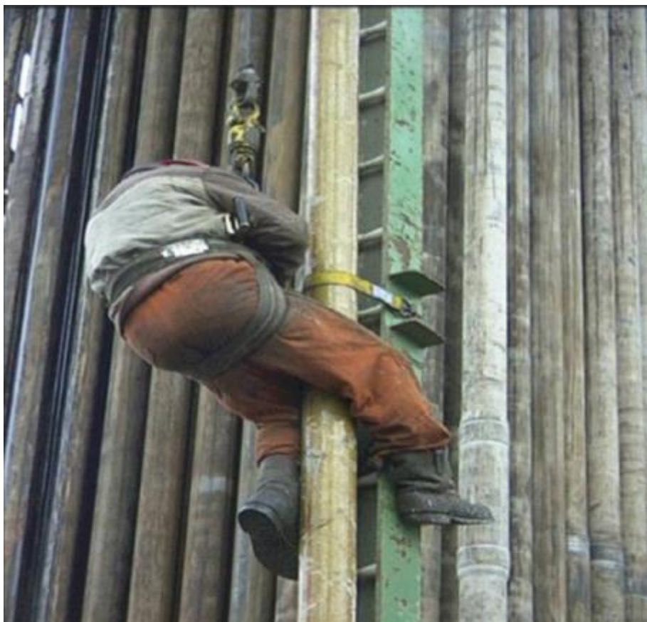
Рис. 17 Фиксация верхней части керноприемной трубы к укладочной раме
